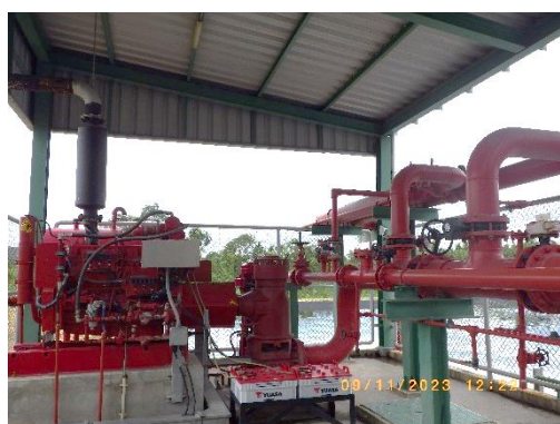
รูปที่ 2-20 ระบบปั๊มดับเพลิง บริเวณสถานีควบคุมระบบท่อที่ 652
