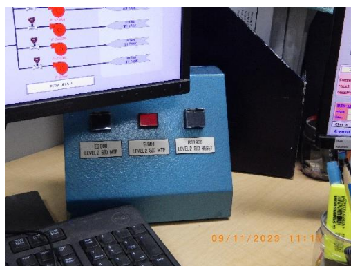
ระบบหยุดปั๊มอัตโนมัติ สถานีสูบน้ำ้ำมันมาบตาพุด
